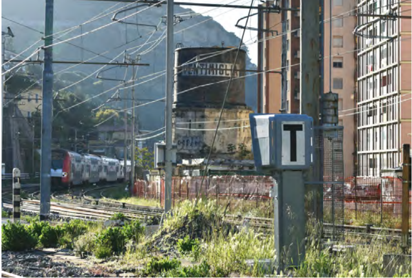
TRATTO FINALE DELLA FERROVIA ITALIANA, DOVE COMINCIANO LE ROTAIE CHE PORTANO IN FRANCIA.
